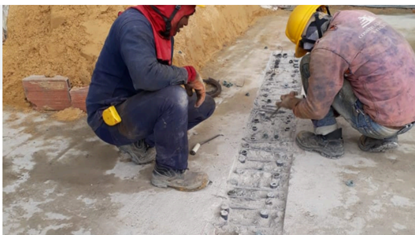
Muros y columnas
